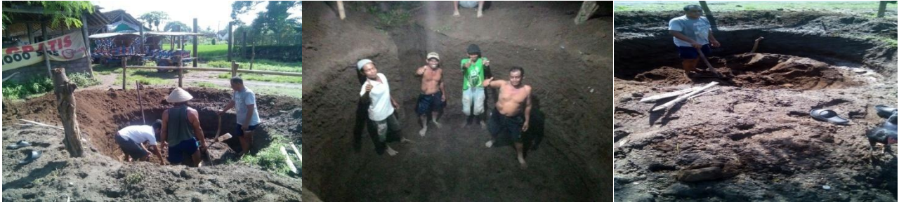
Gambar 2. Pembuatan instalasi biogas
