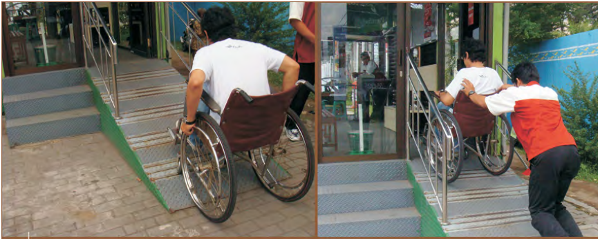
Gambar 6. Ramp yang curam mustahil untuk diakses mandiri oleh pengguna kursi roda (Sumber: Laporan Life Design Project, 2009)
