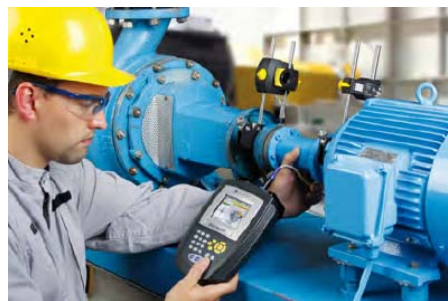
Gambar 3. Seorang operator menguji kualitas sambungan poros menggunakan modul laser shaft alignment (sumber: www.ne-spintech.com/ )
