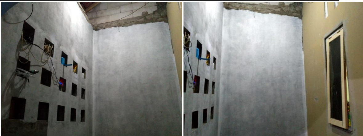
Gambar 6 Ruangn Uji coba
