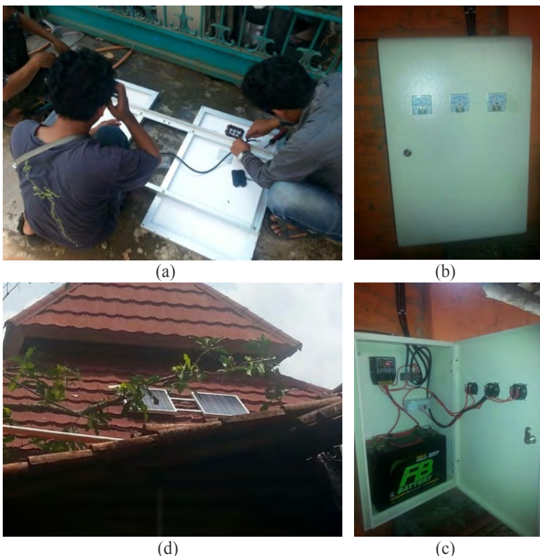
Gambar 3 Pemasangan sel surya (a) Perakitan sel surya, (b) Controller dari luar, (c) Controller di dalamnya, (d) Sel surya di atas mushola putri pondok pesantren.
