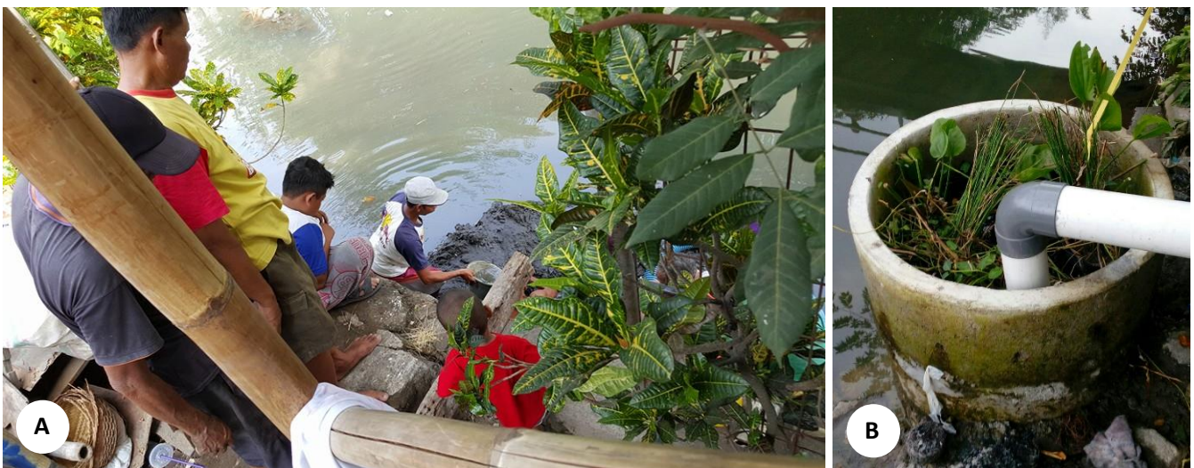
Gambar 7 (A) Kegiatan Pemasangan alat pengolah limbah sungai nanocarbon terintegrasi dengan Bioremediasi. (B) Alat pengolah limbah sungai nanocarbon terintegrasi dengan Bioremediasi sudah terpasang sebanyak 3 titik sepanjang 100 m.
