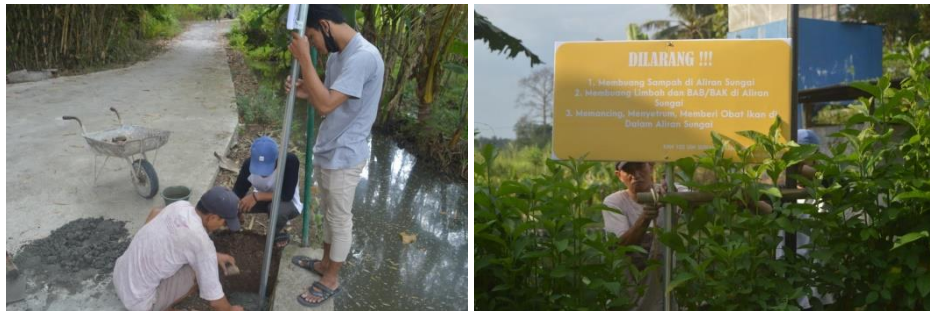
GAMBAR 2. Proses pemasangan rambu-rambu peringatan.
