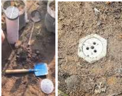
Gambar 3. Biopori paralon (kiri) dan paving block (kanan)
