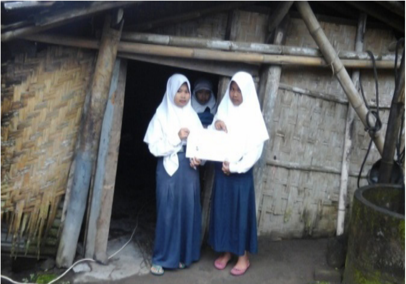
Gambar 1. Penampakan rumah sebelum direnovasi (sumber: Lazismu PCM Kalasan)
